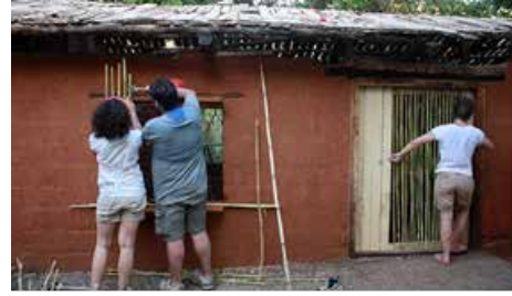
Şekil 6. Akop Ovakent Uygulama Atölyesi 2
