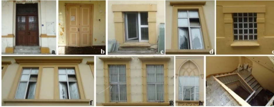
Şekil 4. Hamidiye Hastanesi Mimari Elemanları (a) Doğu Cephe Giriş Kapısı b) İç Kapı c) Kuzey Blok Pencere d,f) Kuzey Blok Birinci Kat Pencere e) Güney Blok Pencere g) Güney Blok Birinci Kat Pencere h) Doğu Cephe Pencere i) Merdiven)
