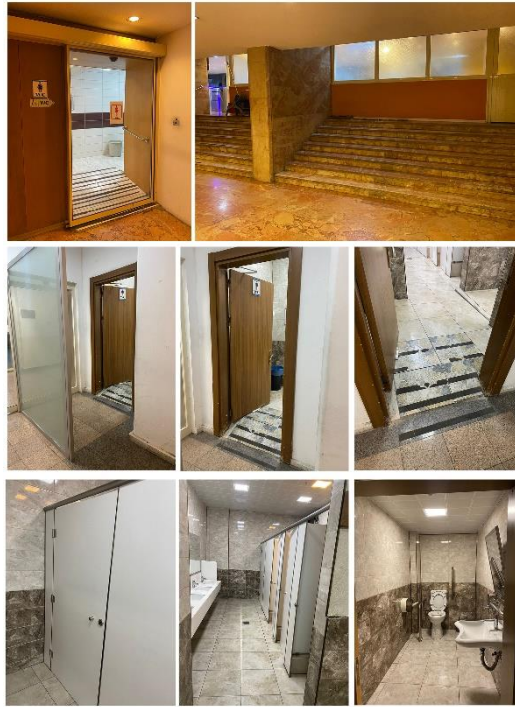
Şekil 1. Milli Kütüphane WC Mekanları
