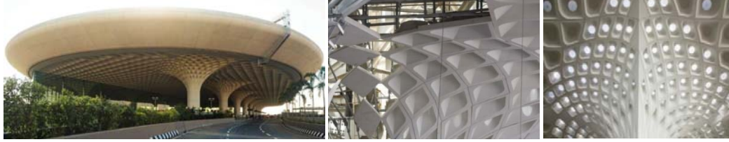
Resim 13. GFRC Kaplı Konsollu Çatı ve Kolonlar ile Tavandaki Işıklıklar 10
