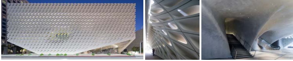
Resim 8. Genel Görünüm, Önden Kalıplanmış ve Püskürtme GFRC Uygulaması 5
